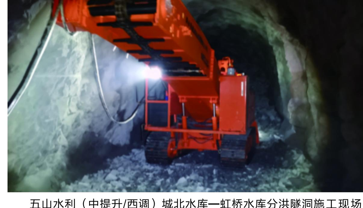
五山水利(中提升/西调)城北水库—虹桥水库分洪隧洞施工现场的“秘密武器”——大功率扒渣机。
